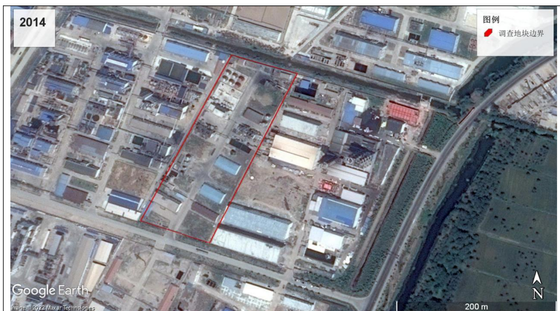
摄于 2014 年 5 月（凯欣化工生产中，与 2012 相比，西北侧新增罐区和三车间）
