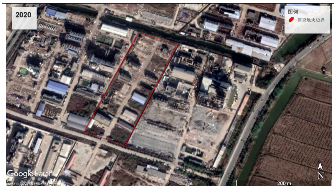
摄于 2020 年 11 月（拆除中）
